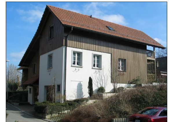
Bewilligter Wiederaufbau 1993 vom «alten Speicher»
