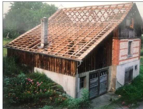
Vorbereitung zum bewilligten Rückbau vom «alten Speicher»
